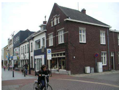
Stationsstraat hoek Boermansstraat
