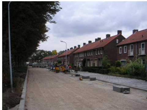
Wederopbouw aan de Mariënhagelaan
