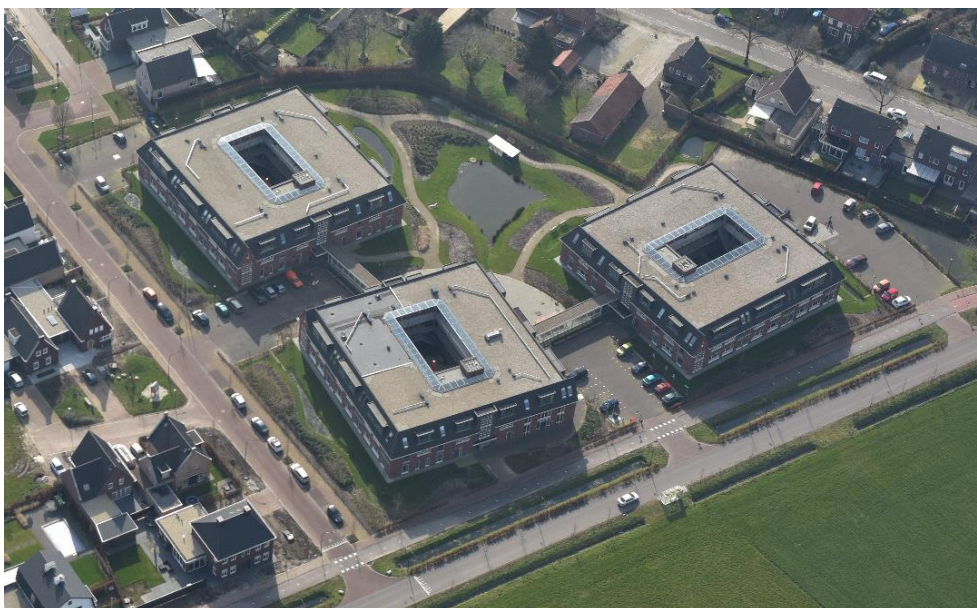
figuur: woonzorgcomplex Hushoven
